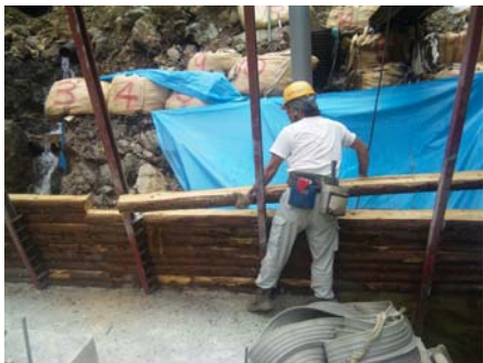
間伐材取付け状況
